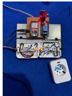
Gambar 7. Pemasangan Komponen pada Papan Panel
