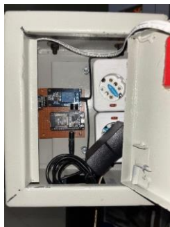
Gambar 8. Pemasangan Alat ke Dalam Box Panel
