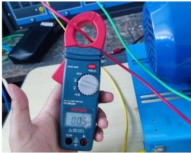
Gambar 9. Pengukuran Arus Pada Fasa R
