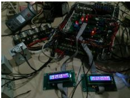
Gambar 7. Pengujian menggunakan motor 3 phasa
