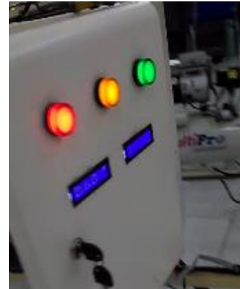
Gambar 8. Gambar pengujian beban kompressor
