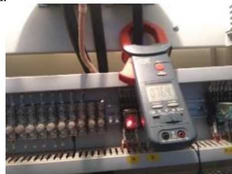
Gambar 9. Pengukuran beban panel di PT.Pancawana Indonesia.
