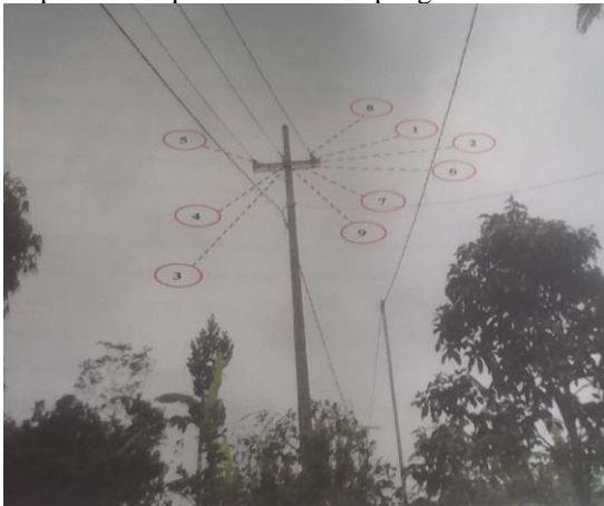
Gambar 4. Kontruksi Tiang Akhir Tarik TM 4
