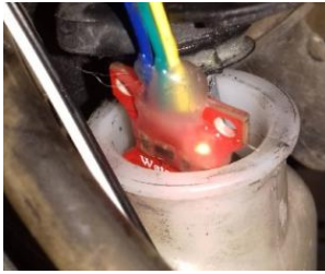
Gambar 11. Pemasangan sensor water level
