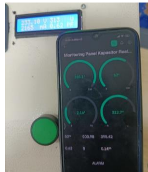
Gambar 11. Pengujian Motor 1phase Dan Bor Listrik Sebelum
