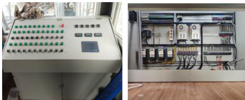
Gambar 4. Perakitan dan Instalasi Panel kontrol Mesin AMP
